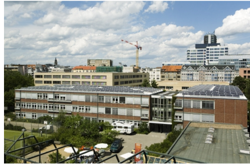
Die Friedensburg-Oberschule in Berlin-Charlottenburg mit einer 65-kW-Anlage.
